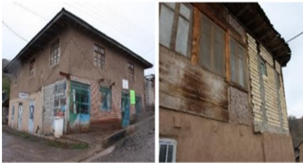
تصویر ۸. نمونه‌هایی از آسیب‌پذیری مسکن در روستای گوغل - ترکیب مصالح ناهمگون، (۱۳۹۱)
