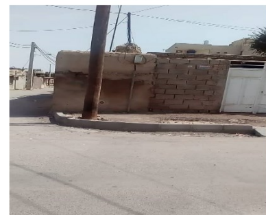
شکل ۶: عبور نامطلوب کابل‌های برق و نصب لوله‌های گاز در جداره خارجی ساختمان‌ها بر دامنه خطرهای ناشی از آتش‌سوزی می‌افزاید. (منبع، نگارندگان)
