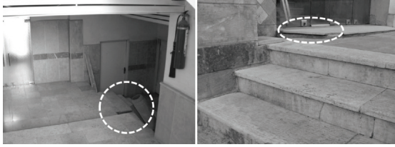
تصویر ۱۰: اختلاف سطح تک‌پله و شکستگی پله‌های ورودی، نبود نرده در پله
