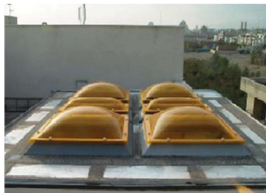
تصویر ۱۰: نور گیر سقفی سکوی ایستگاه متروی ترمینال جنوب [۱۲]
