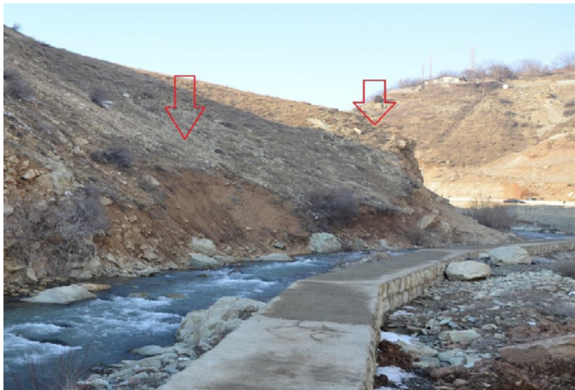
(شکل شماره ۶) ۲ زمین لغزش کنار رودخانه در جاده گلوکان به حاجی آباد
