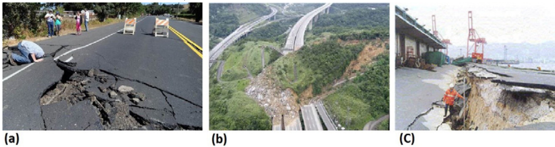
شکل ۱. خرابی راه در اثر (a) گسلش، (b) زمین لغزش و (c) روانگرایی
