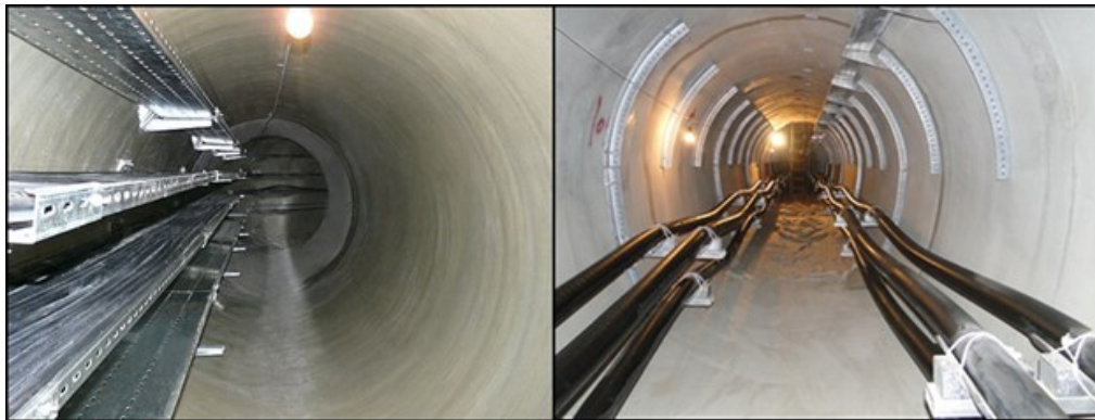
شکل ۵. تونل تأسیسات بولوار امیرالمؤمنین (ع) شهر مقدس مشهد
