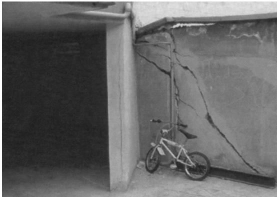
تصویر شماره ۵ (۵): نشست زمین و آسیب دیدگی ساختمان‌های نوساز در جنوب میدان فتح (منطقه ۹)، [۱۲]
