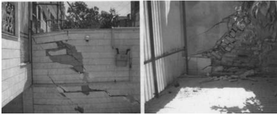
تصویر شماره ۷: نشست عمومی تعدادی از ساختمان‌ها به دلیل ریزش ائبوری چاه‌های فاضلاب (منطقه ۱۰)، [۱۳]
